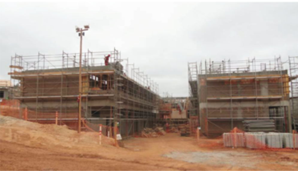
Construção da nova escola em Conceição do Mato Dentro
