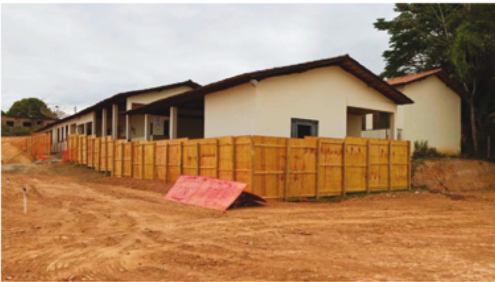
Ampliação da Escola Municipal José Aniceto Costa, em Conceição do Mato Dentro
